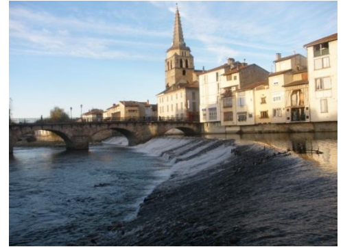
Centrale du Moulin - 2x80KW
