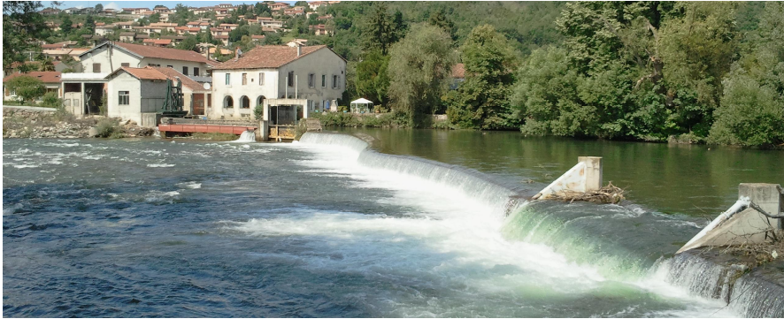
Centrale du pont du Baup - 1x220KW
