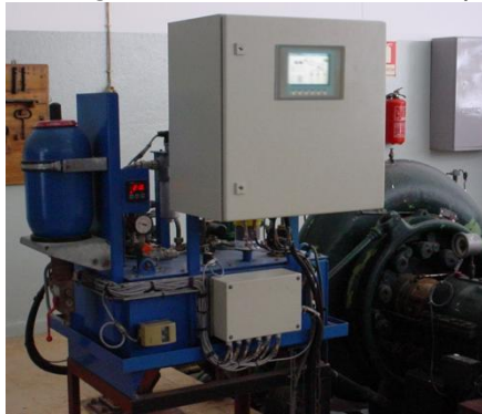
Nuevo regulador instalado en el grupo hidráulico de pilotaje Turbina Francis 400KW
