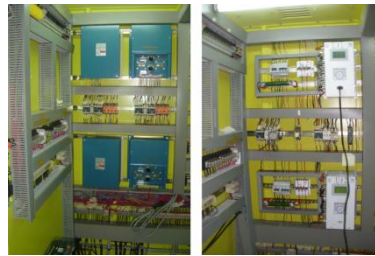
Ante Después Los reguladores son instalados en lugar de los antiguos...
