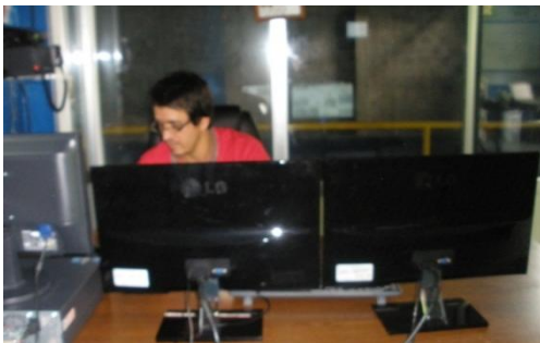
Operador frente al SCADA
